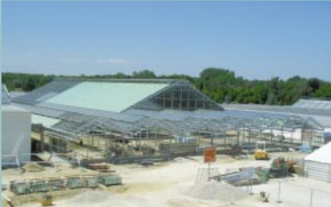
Die Großbaustelle in Rain am Lech
