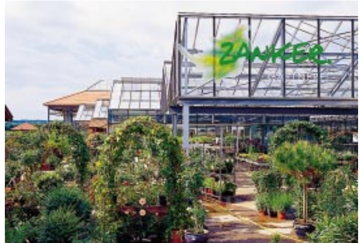
4 und 1/2: Die versetzt arrangierten Schiffe
