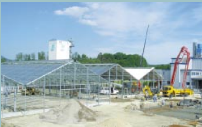
Große Baufortschritte in Reutlingen
